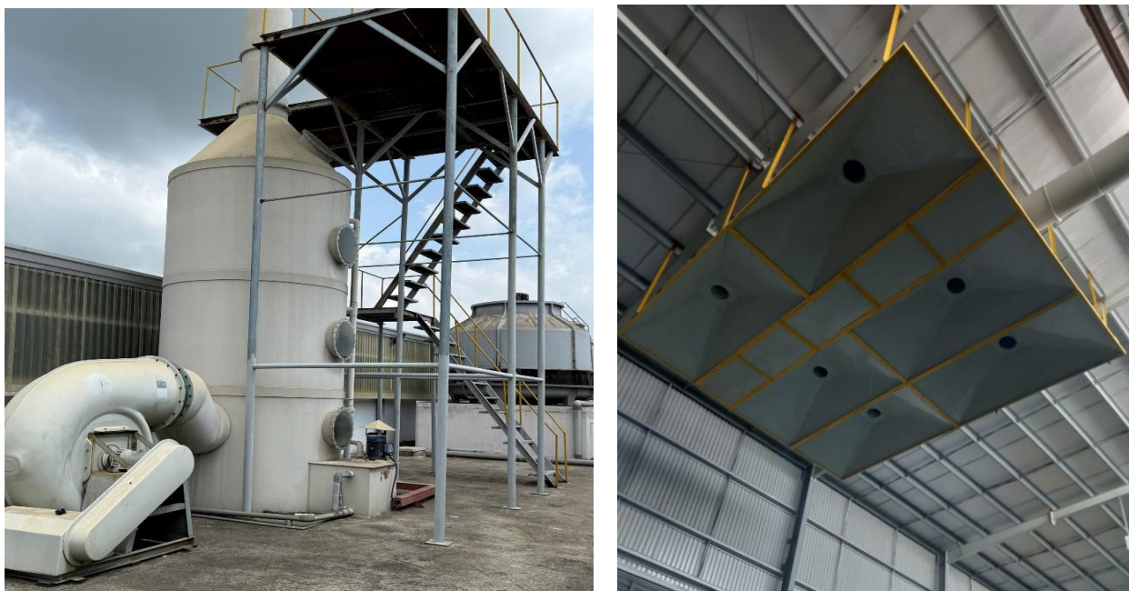
Hình 3.13. HTXL khí thải anod hoá bề mặt công suất 20.000 m 3 /h
