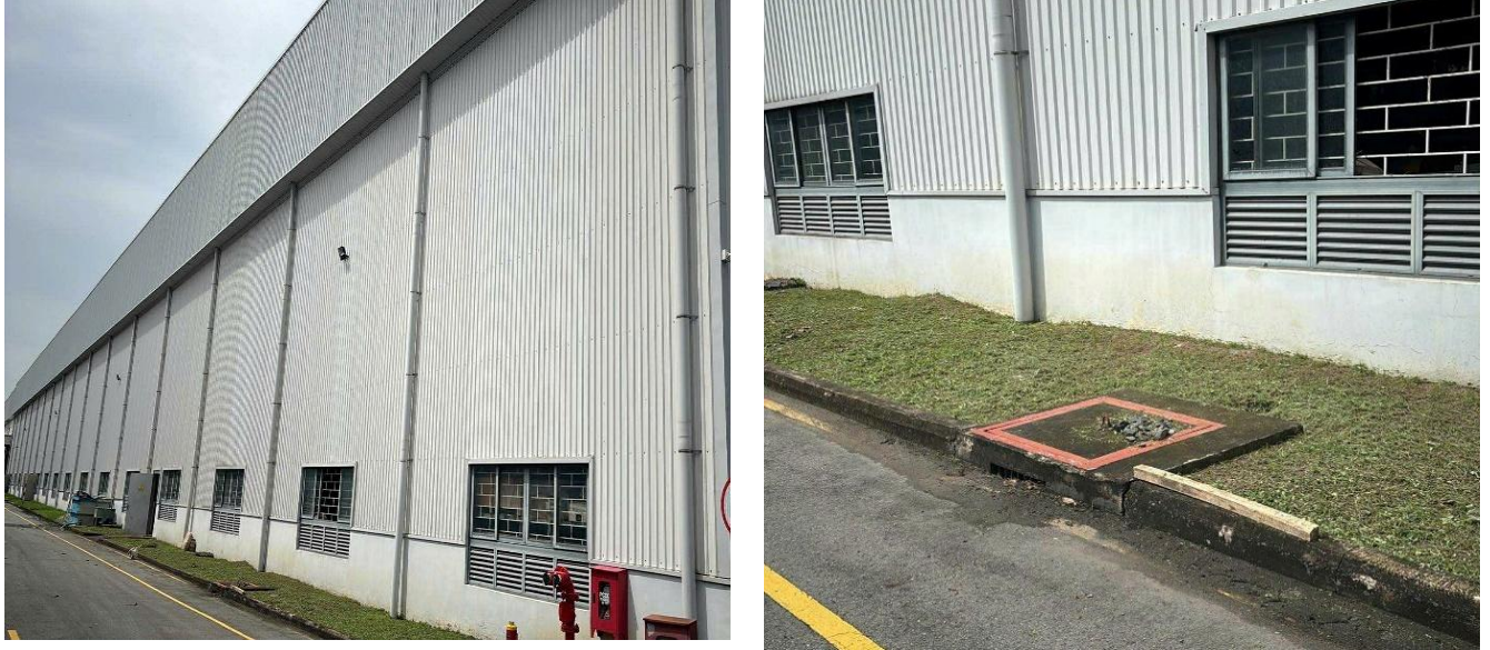
Hình 3.2. Mương thu gom, thoát nước mưa của cơ sở
